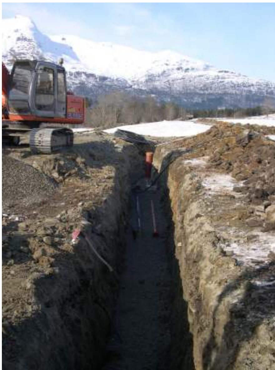
Grøftarbeid i spreidd busetnad
